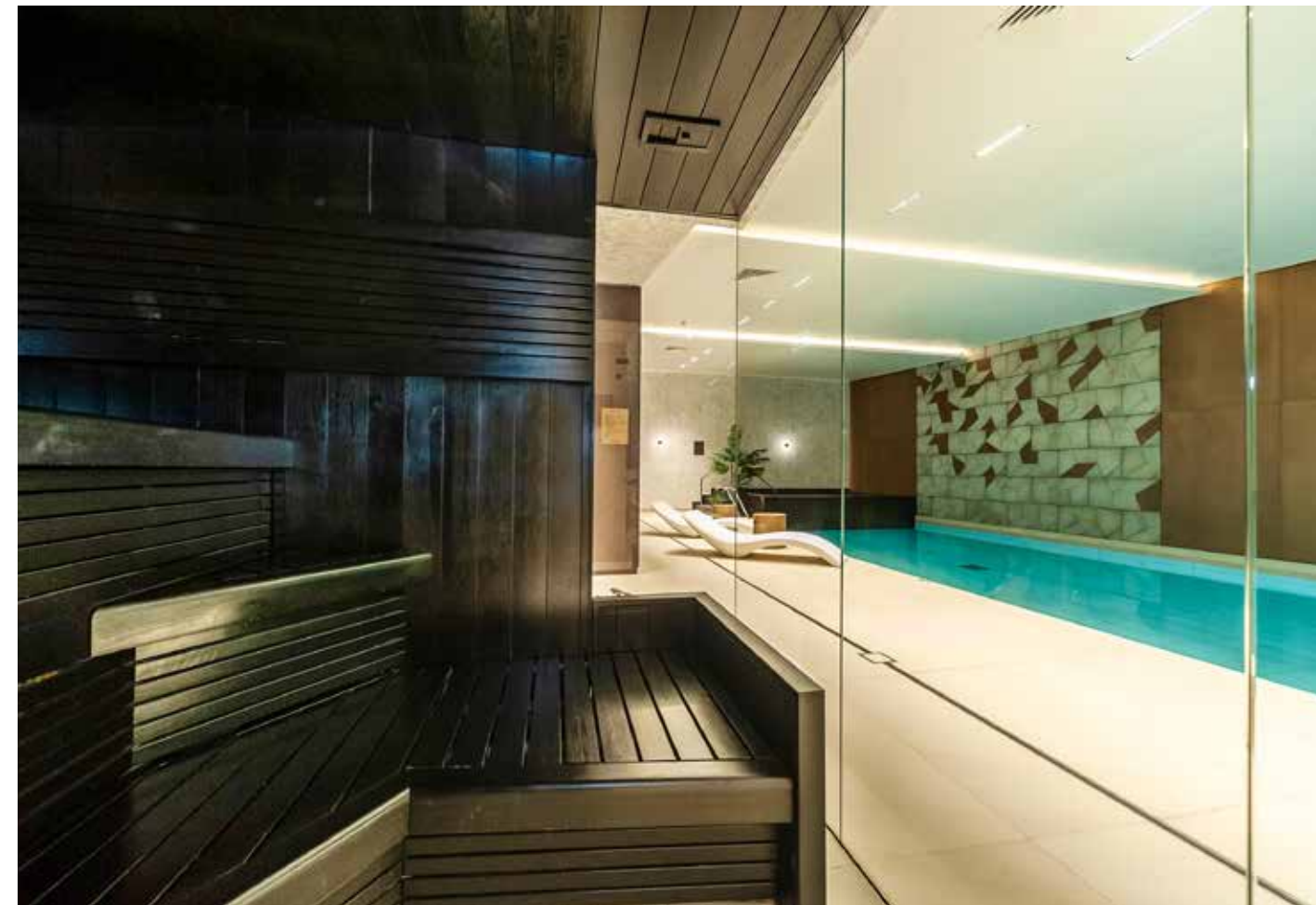
Ainutlaatuinen kokonaisuus, jossa luonnolliset leppäpaneelit on käsitelty mustalla saunavahalla: seinät STS4 15 x 140 mm ja lauteet SHP 28 x 90 mm. YKSITYISSAUNA, ISO-BRITANNIA
