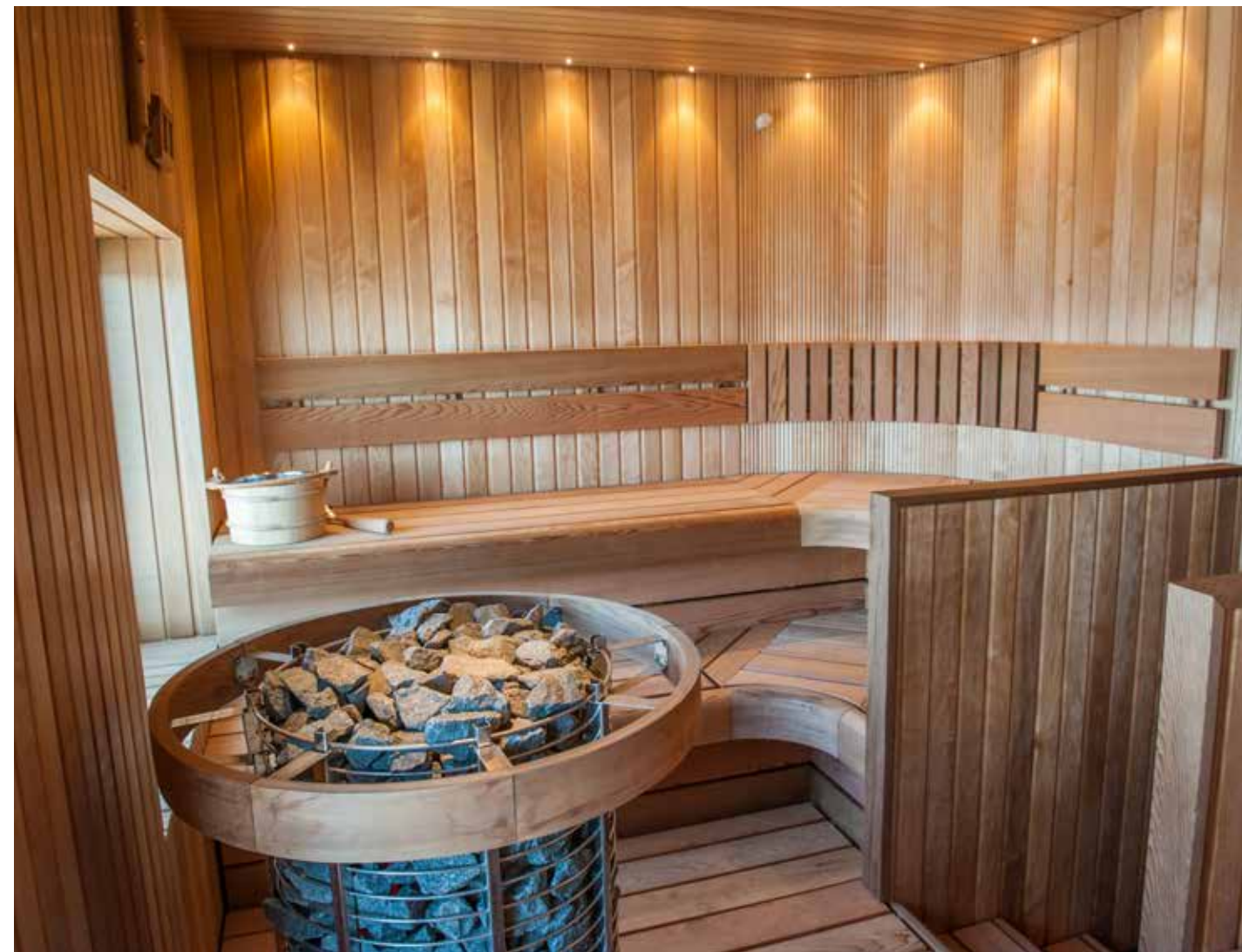
Tässä saunassa on onnistuneesti yhdistelty erilaisia lämpökäsiteltyjä materiaaleja: seinät STP 15 x 90 mm ja SRP 15 x 82 mm haapaa, lauteet radiatamäntymoduuleista SHP 26 x 140 mm. QUALITY HOTEL LAPLAND, RUOTSI
